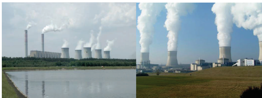
Slika 10. Termoelektrane i nuklearke
