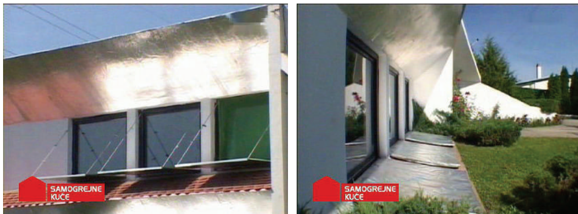
Slika 2. Reflektujući paneli u trećoj deceniji upotrebe. Kako se na fotografijama vidi, donji paneli su pokretni.
